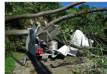
▲倒木が直撃した防災倉庫
