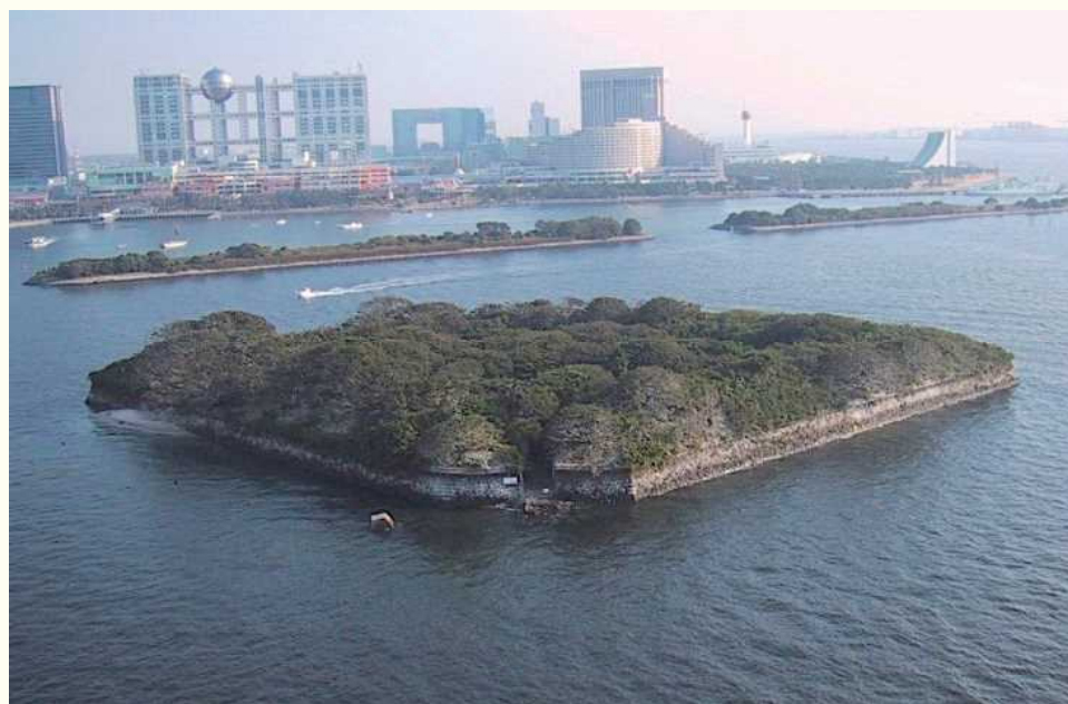
江戸時代に作られた台場の内現存する第6台場
